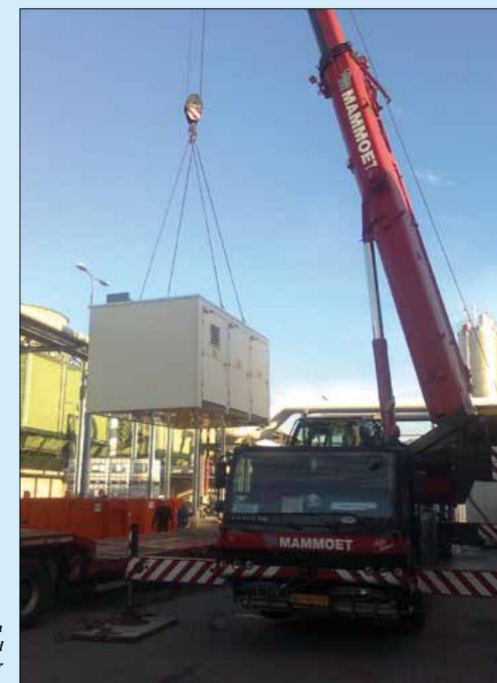
Een grote kraan hijst het hele skid in een keer naar zijn plaats.
