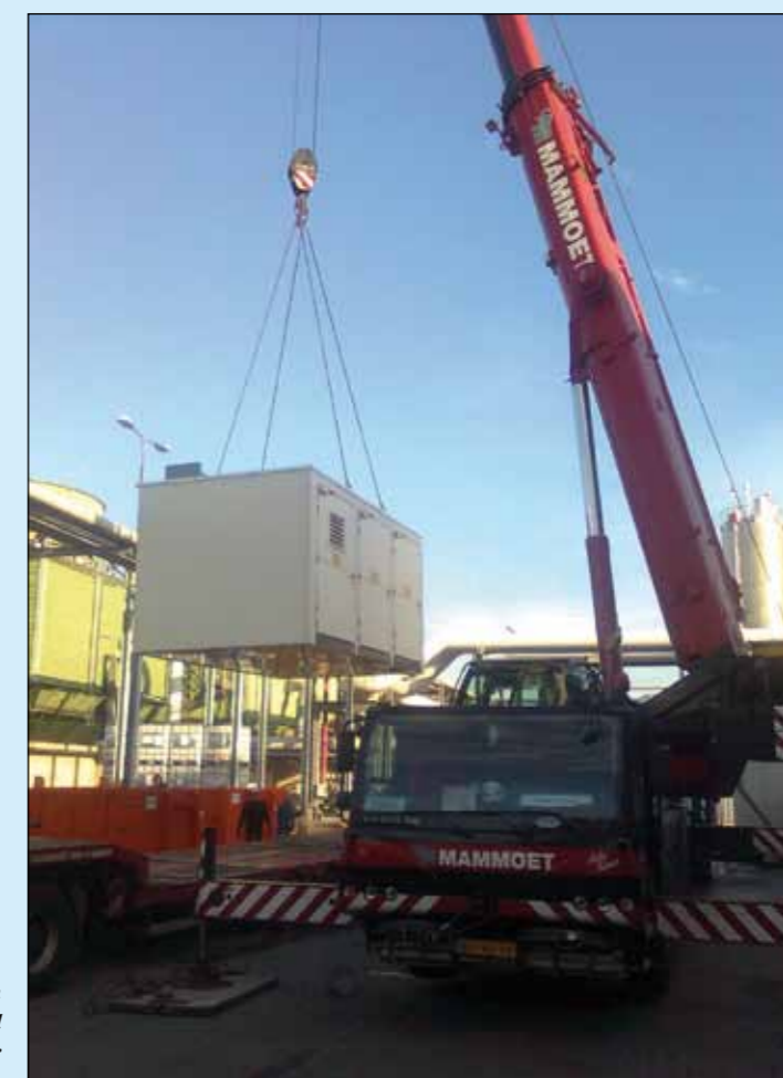
Een grote kraan hijst het hele skid in een keer naar zijn plaats.
