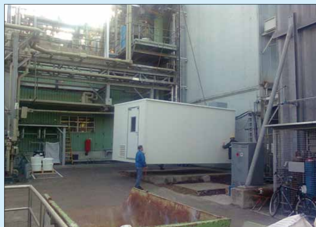
De skid kwam door plaatsgebrek buiten het pand te staan.
